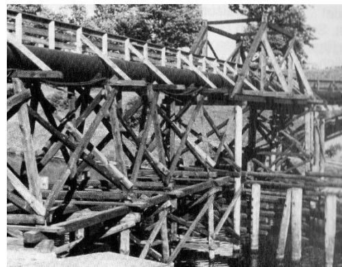
Behelfsbrücke Buschkrugallee Mai 1945
